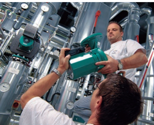
Vorbereiten einer Reservepumpe zum Einbau in den Heizkreislauf. Die Pumpe wird zentral gesteuert.
