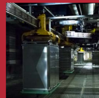
Die automatische Warentransportanlage vom Schnarrenberg: Das umfangreiche Schienennetz und 480 Transportwagen wollen vom tba gepflegt werden.
