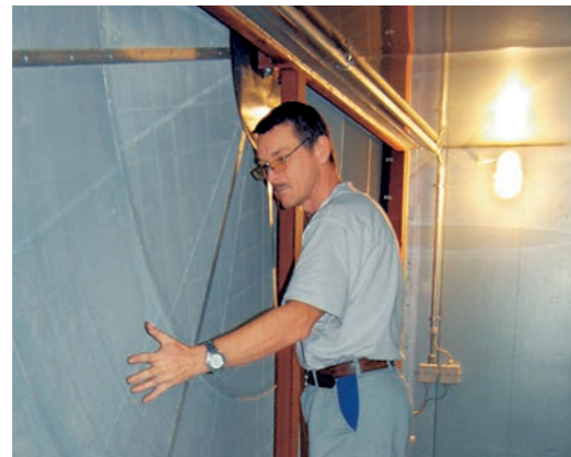
Effiziente Wärmetauscher in der CRONA: 8 Wärmeräder zur Wärmerückgewinnung mit 4 m Durchmesser erwärmen 700.000 m 3 Luft pro Stunde um bis zu 30 K.
