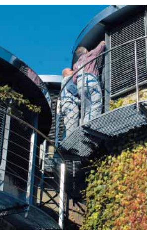
Frische Luft für die CRONA: Die Reinigung der Wetterschutzgitter geschieht halbjährlich.
